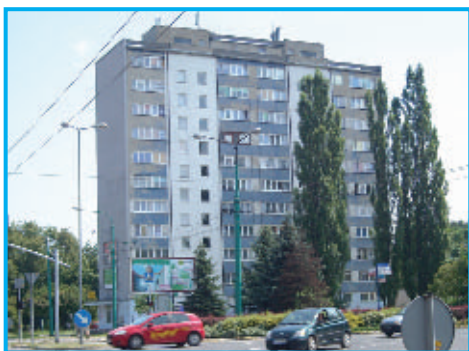
Fot.3. Charakterystyczny, jeden z wielu dziesięciokondygnacyjnych budynków serii „540”
