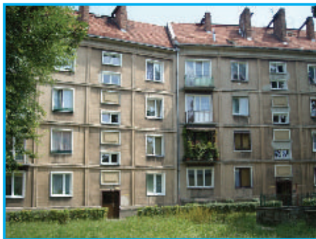
Fot. 2 Budynek na os. „C1”
