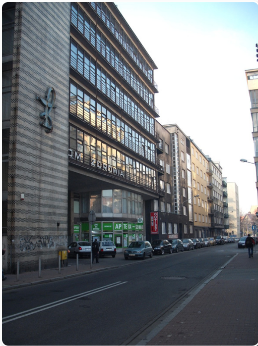
Dom Zdrowia Budowlanych, widok dzisiejszy, zdemontowany napis „BUDOWLANYCH”
