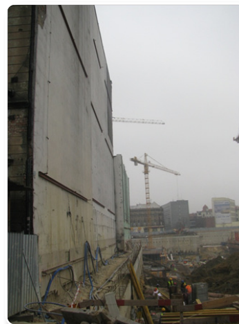
Roboty przy istniejącej zabudowie - ul. Słowackiego
