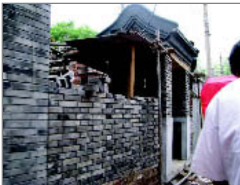
Budowa budynków z czarnej cegły.
